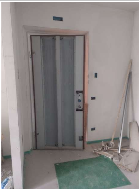
Portone ingresso blindato senza pannello posteriore soluzione tipo per tutti gli immobili
