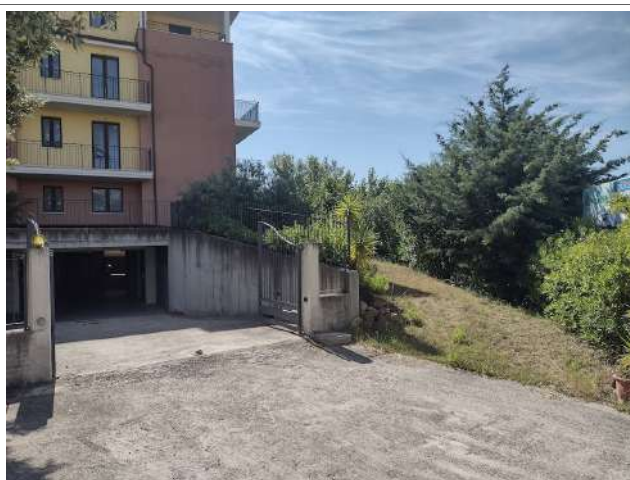
Ingresso carrabile e raccordo corte sub 2 lato sud
