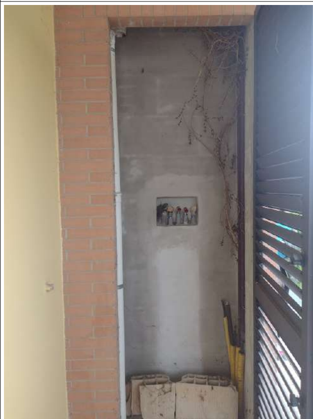
Esterno box caldaia
