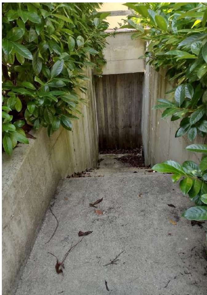
Percorso esterno sub 3
