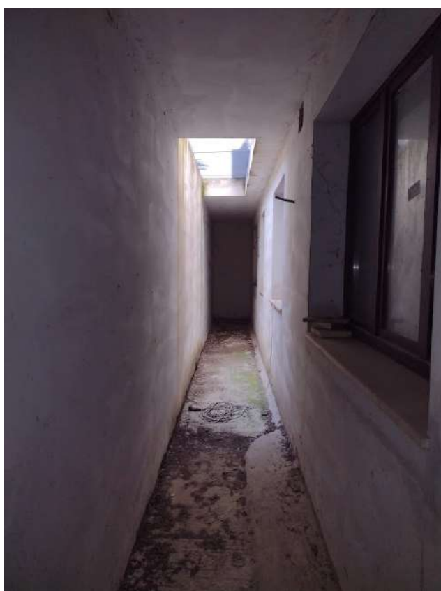
Interno cavedio sub 20
