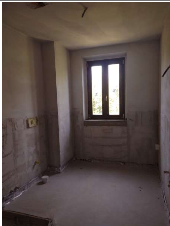
Interno sub 21 bagno
