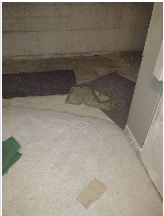
Loc tecnico p. s2
