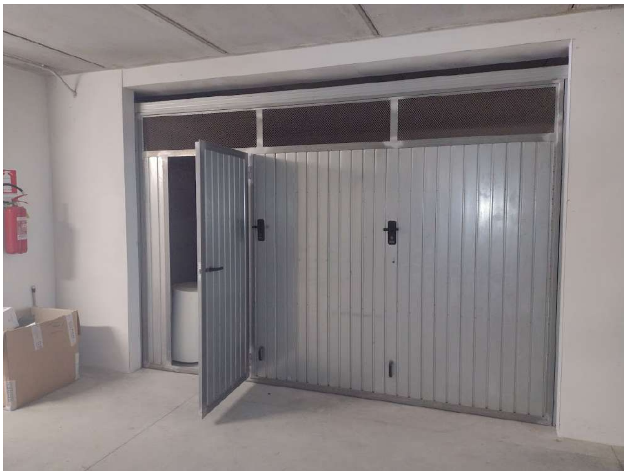
Particolare tipo serranda basculante e porta pedonale- struttura con sopra-luce di areazione
