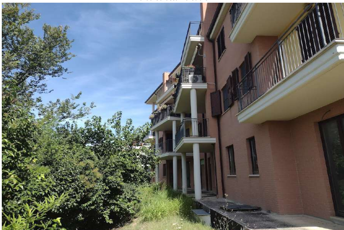
part vista esterno prospetto sud con corte esterna sub 21 e sub 2
