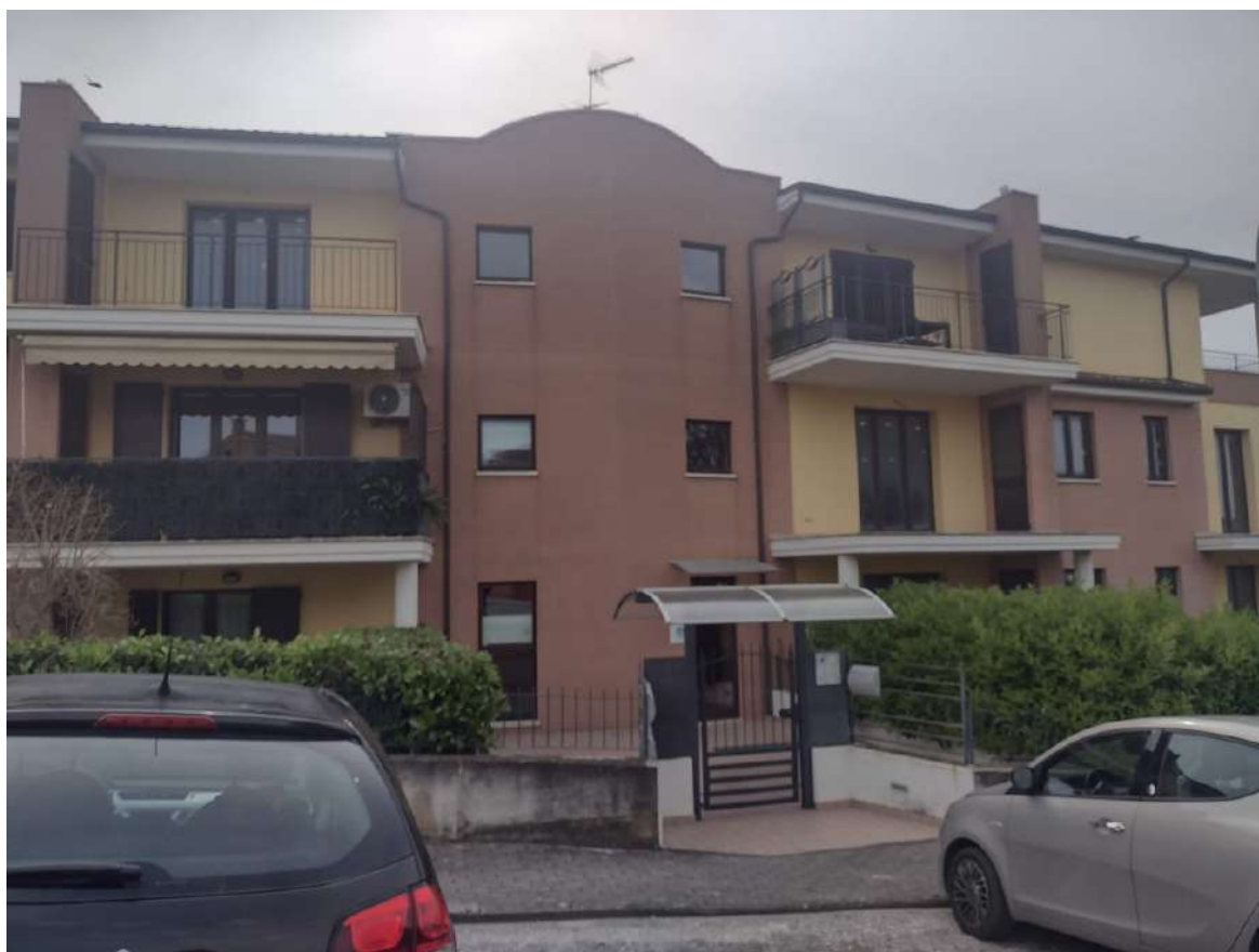
prospetto nord via Robert.B.Pawell- ingresso principale p.terra
