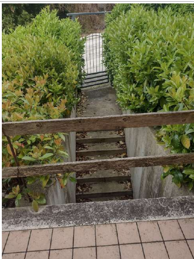
Esterno su percorso esclusivo sub 3
