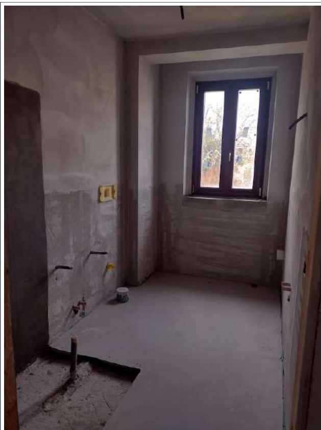
Interno sub 42 . bagno
