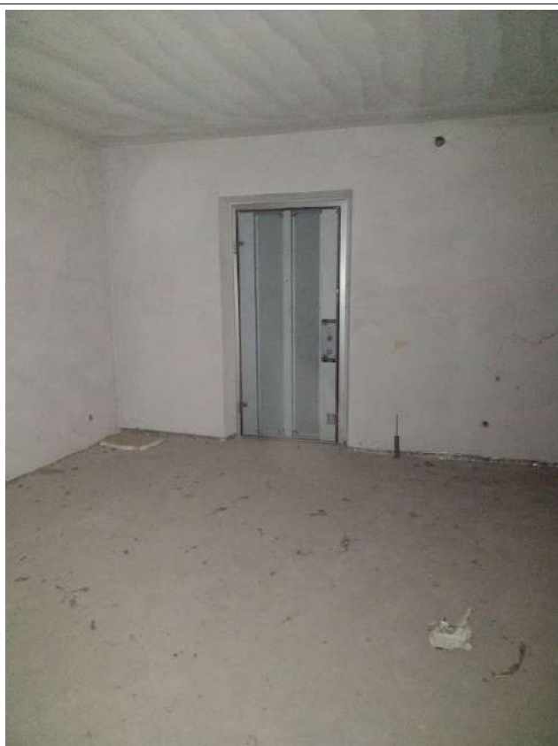
Interno sub 20 – part porta ingresso su vano scala
