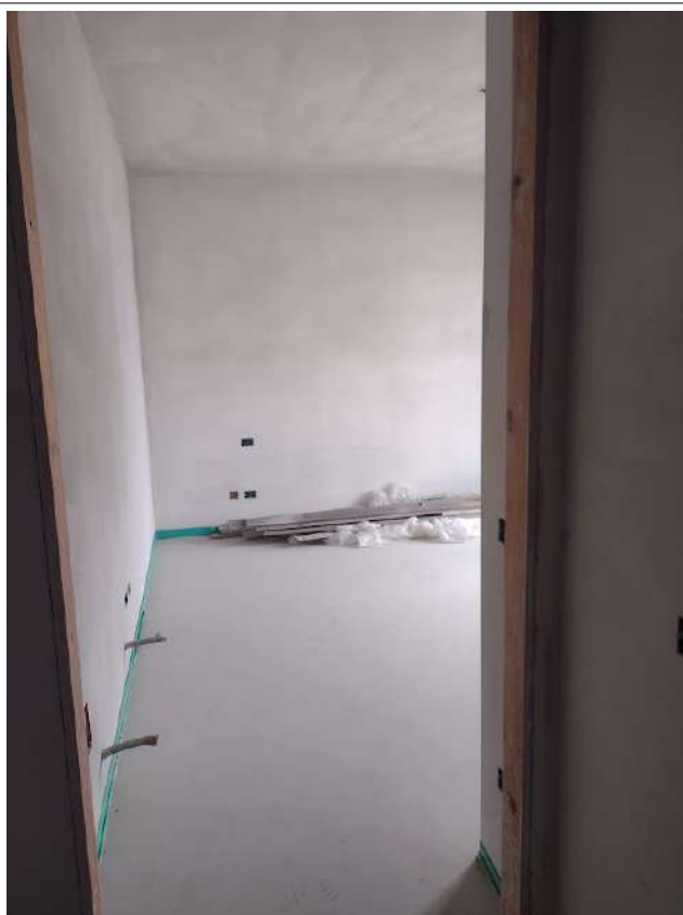
Interno sub 42 bagno
