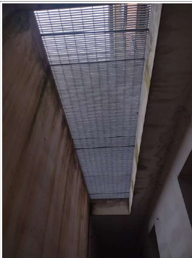
Part. Areazione/luce taglio orizzontale cavedio sub 20
